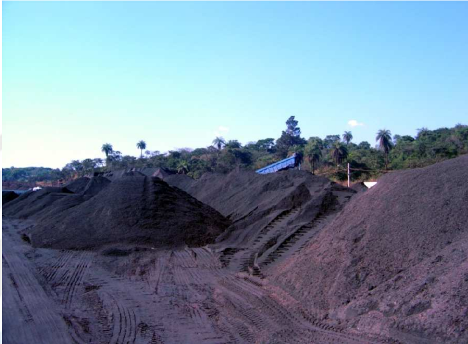
Figura 7 - Área de armazenamento de Minério de ferro, já existente
